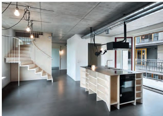
Küchenblock und Treppe sind aus Holzplatten gebaut.
