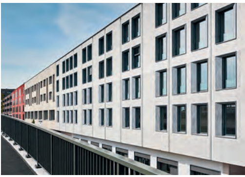
Variierende Fenstergewände beleben die Fassaden.
